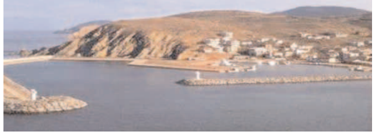
Erdek Şahinburgaz Balıkçı Barınağı İnşaatı
