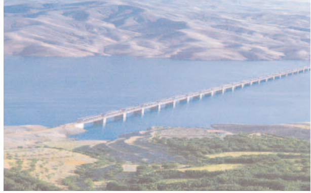
Karakaya Demiryolu Köprüsü
