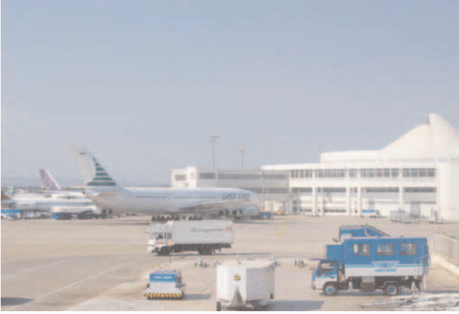
Antalya Hava Limanı I. Dış Hatlar Terminal Binası , 54.000 m 2 ve 5 Milyon yolcu/yıl kapasiteli olup, 1998 yılında hizmete verilmiştir.
