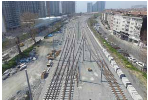
Hat Üstyapısı - Avrupa (Zeytinburnu-Yenimahalle İstasyonu Arası Hat Serimi)
