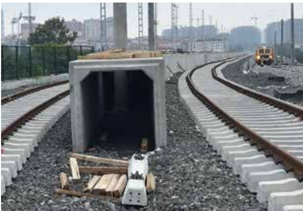
Yenimahalle Gare Sahası Çalışmaları
