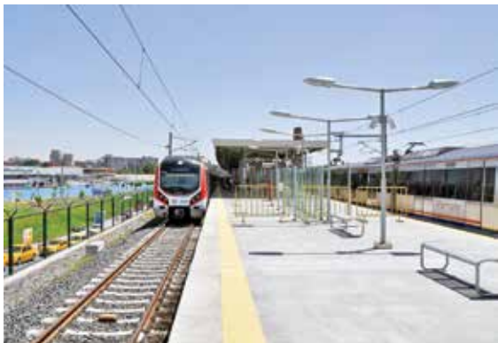
Kazlıçeşme İstasyonu Peron Kati
