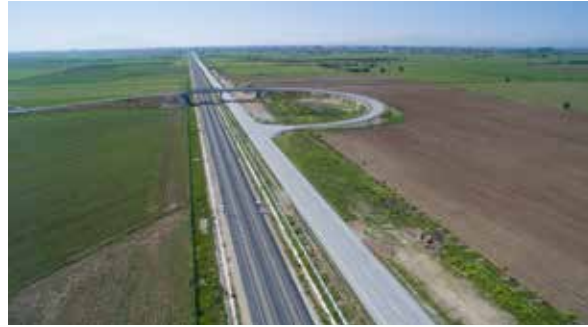
Konya-Karaman Hızlı Demiryolu Hattı (Çumra Mevkii Karayolu Geçişi)
