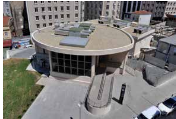
Sirkeci Batı Havalandırma Binası
