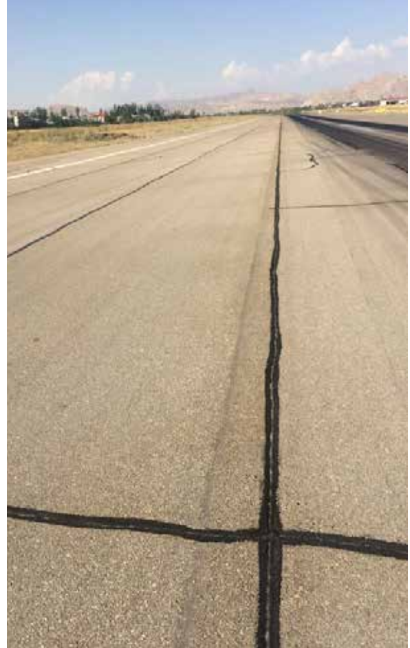
Van Ferit Melen Havalimanı PAT Sahaları Onarımı (DAP) ▼
