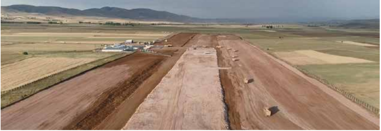
Elazığ Havalimanı Yedek Pist ve İlave Apron Yapımı ve Müteferrik İşler İnşaatı ▼
